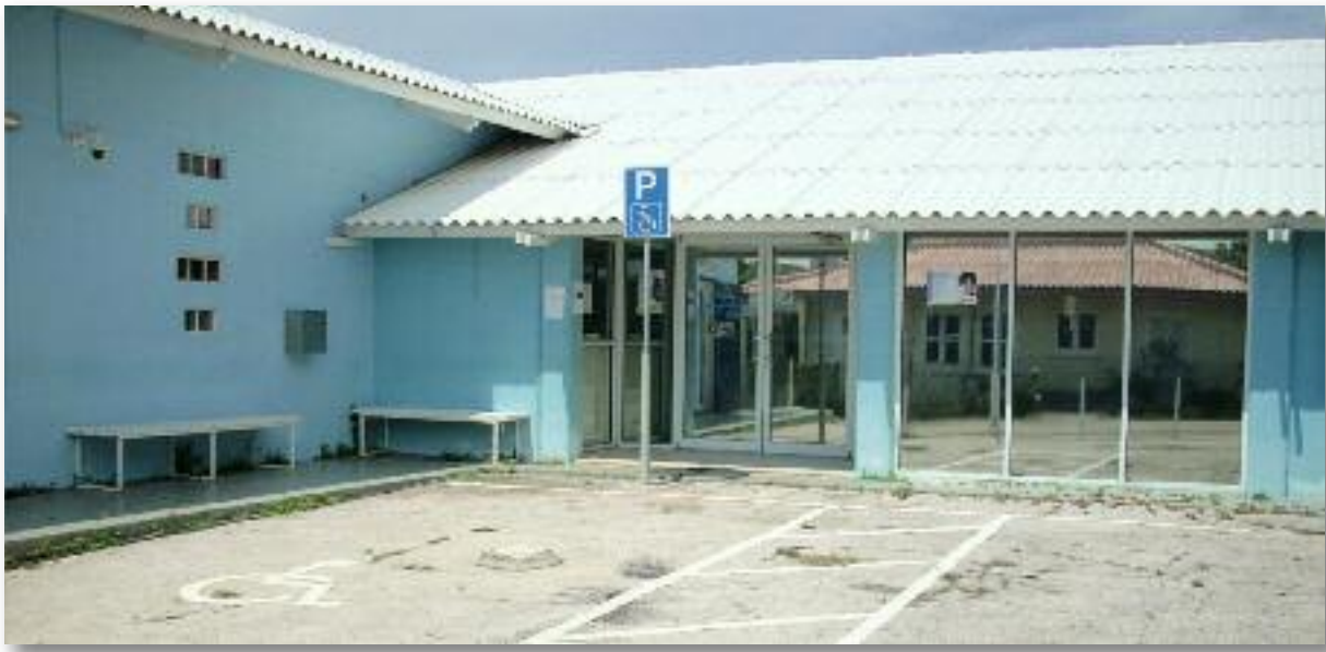
Gebouw Kas di Bario (Ministerie SOAW)
